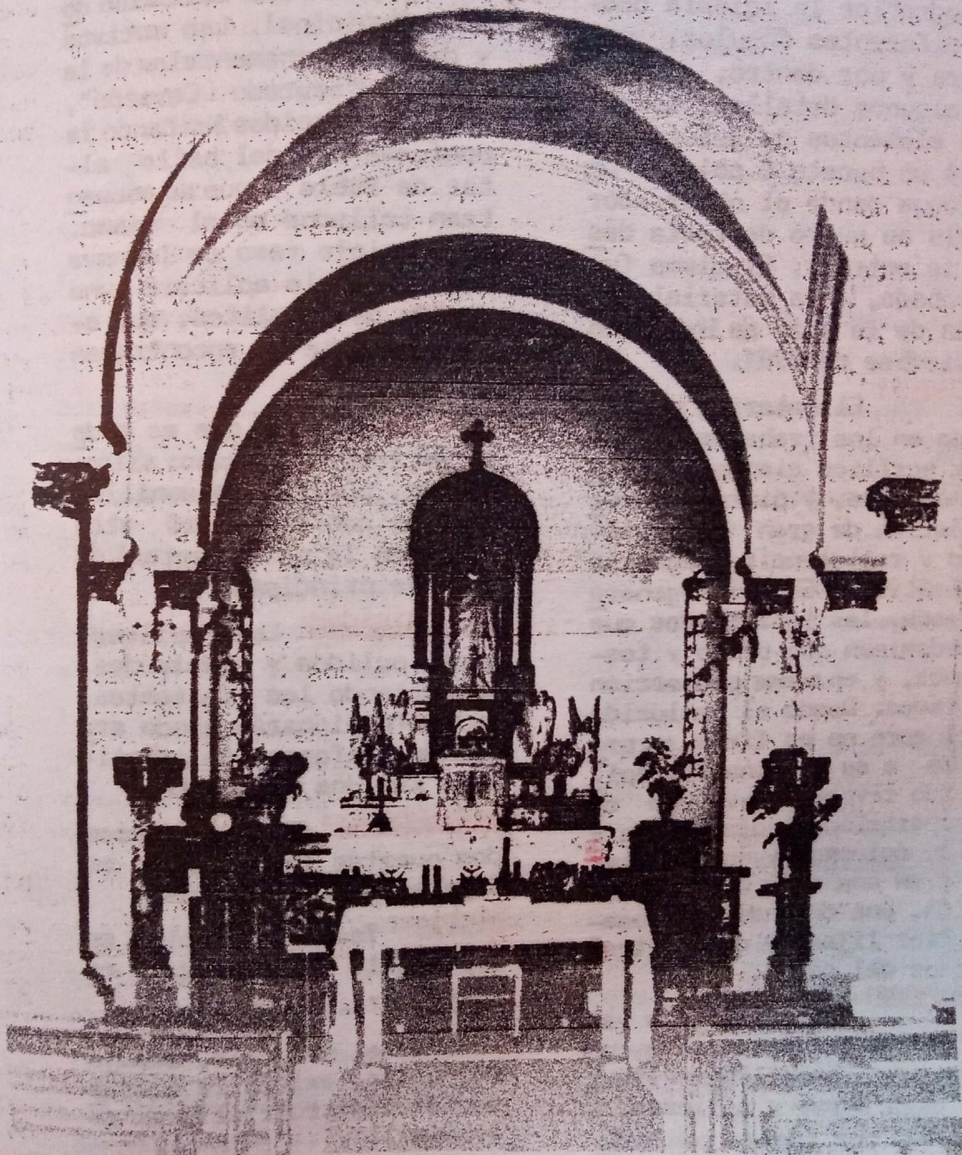
VISTA PARCIAL DEL INTERIOR DE LA CAPILLA
